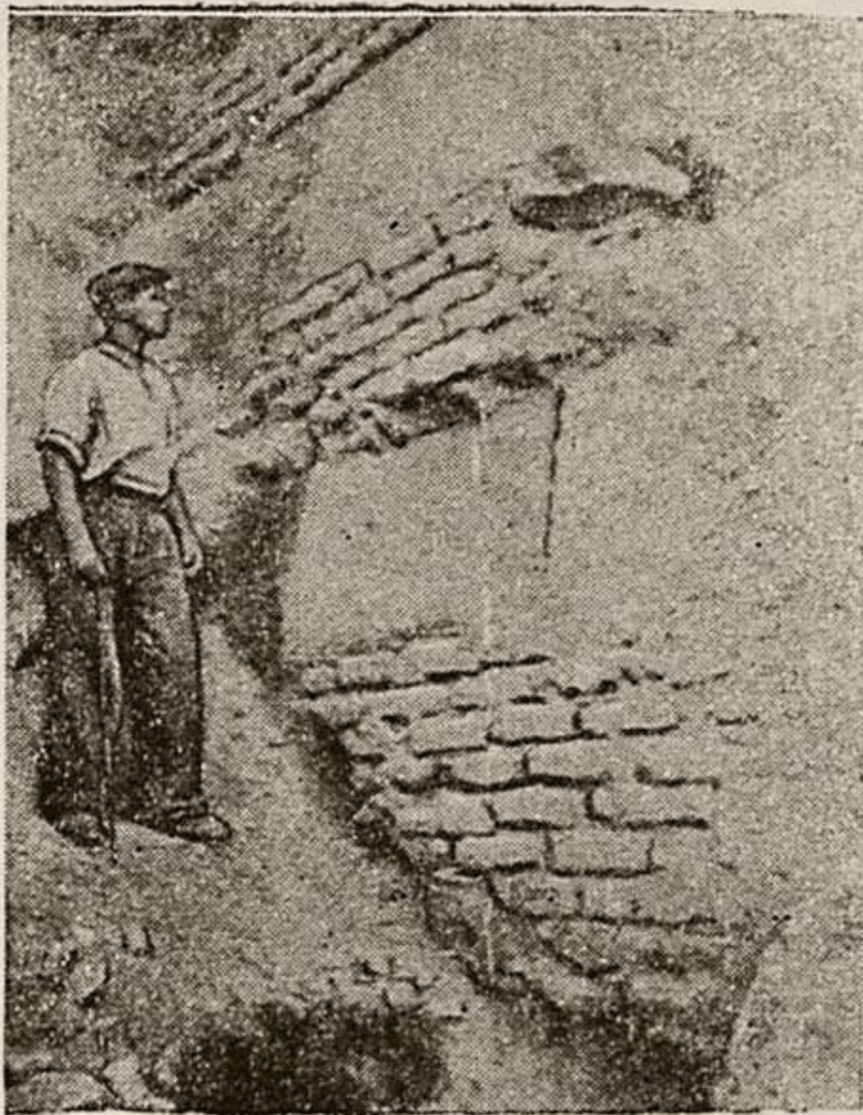
Рис. 1. Участок кладки крепостной стены.
