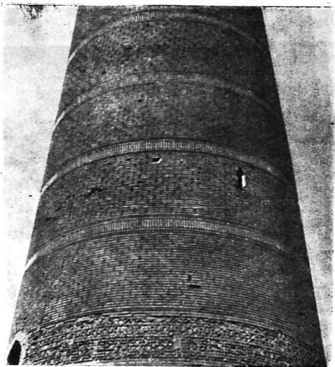
Рис. 54. Куня-Ургенч. Минарет XIV в. Детали облицовки шлифованным кирпичом. Внизу, слева—вход в минарет и лента надписи, скрепленной гипсовым раствором.
