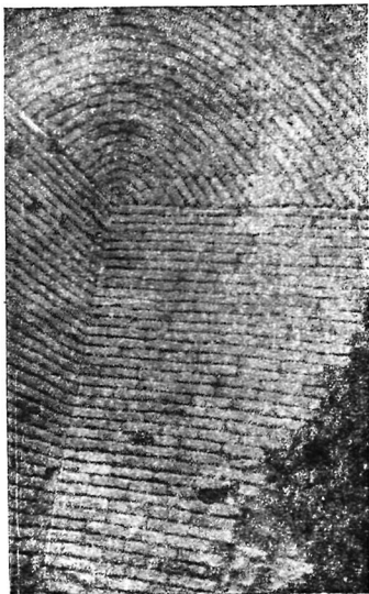
Рис. 34. Дая-Хатын. Кладка угла свода в одной из комнат.
