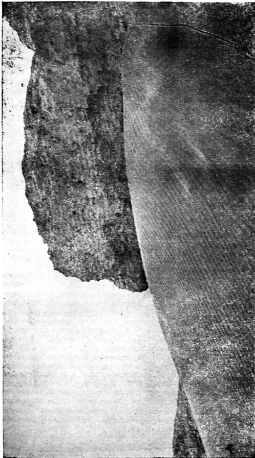
Рис. 40. Куня-Ургенч. Крепость Ак-кала. Разрушение сырцового кирпича под влиянием ветра и влаги.
