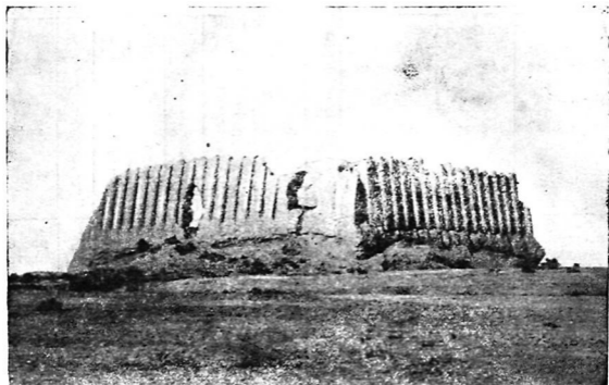
Рис. 25. Древний Мерв. Кыз-кала большая. Левая сторона имеет следы ветровой коррозии.
