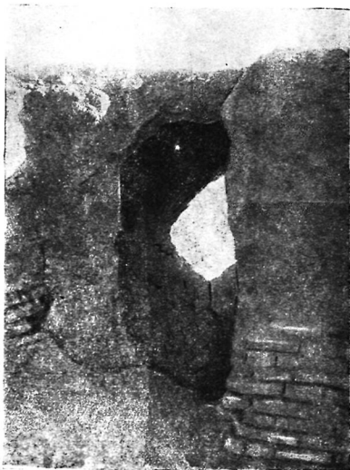
5. Вход в подовую часть печи № 4.
