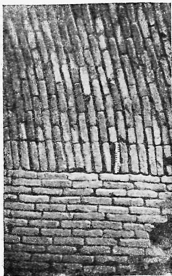
Рис. 35. Дая-Хатын. Кладка стены и свода продолговатой комнаты.
