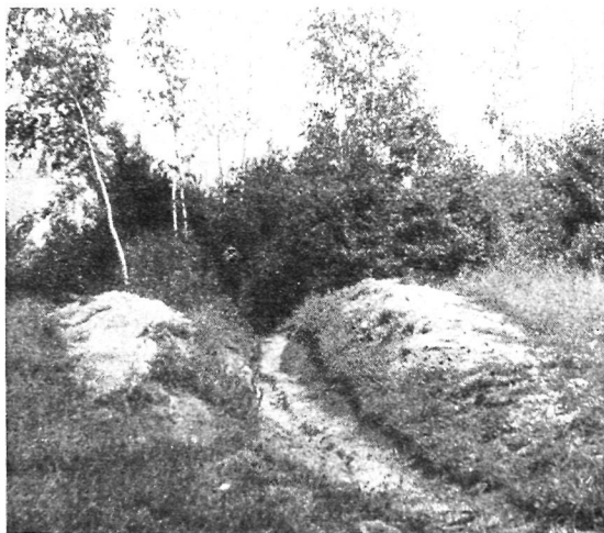
Рис. 15. Выход воды из роци через дренажную канаву.
