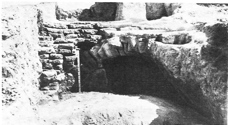
Рис. 58. Объект XXV. Помещение 19. Над сводом — остатки межэтажного перекрытия.
