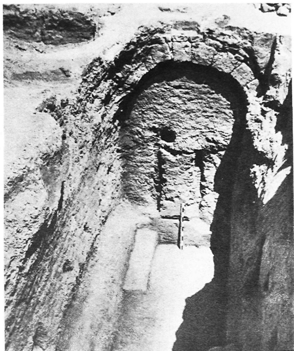
Рис. 57. Объект XXV. Помещение 16, вид с юга. В боковых стенах — гнезда от балок антресолей.
