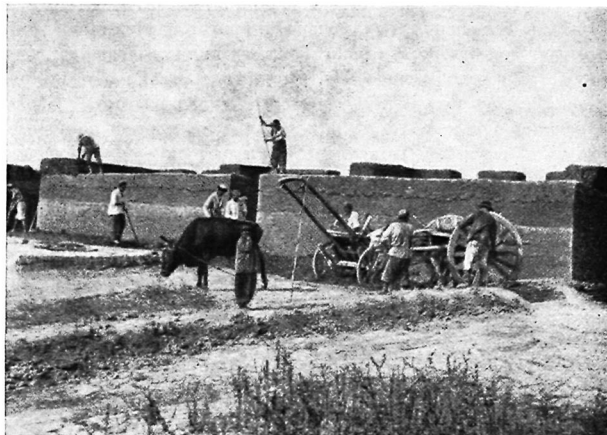
Рис. 34. Постройка дома из пахсы
