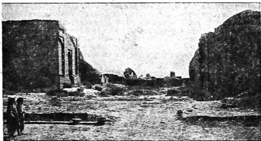
31. Комплекс зданий. Двор. За забором вдали руины здания из сырцового кирпича
