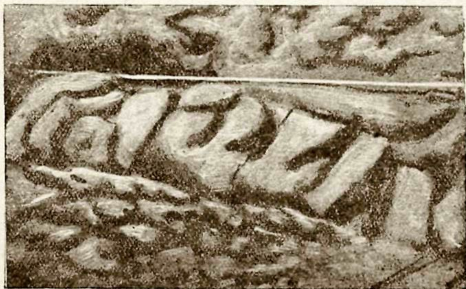
Рис. 17. Сырцовые блоки в кладке крепостной ограды.
