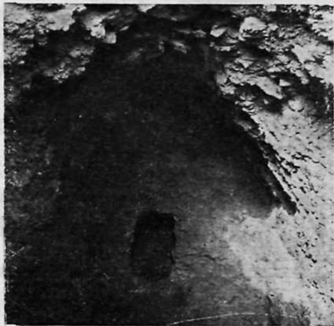
Рис. 86. Квартал керамистов. Свод камеры обжига печи Пч-5.
