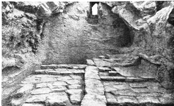
Рис. 14. Центральное здание. Помещение II
