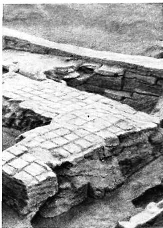
Рис. 126. Останец конструкции пандуса
