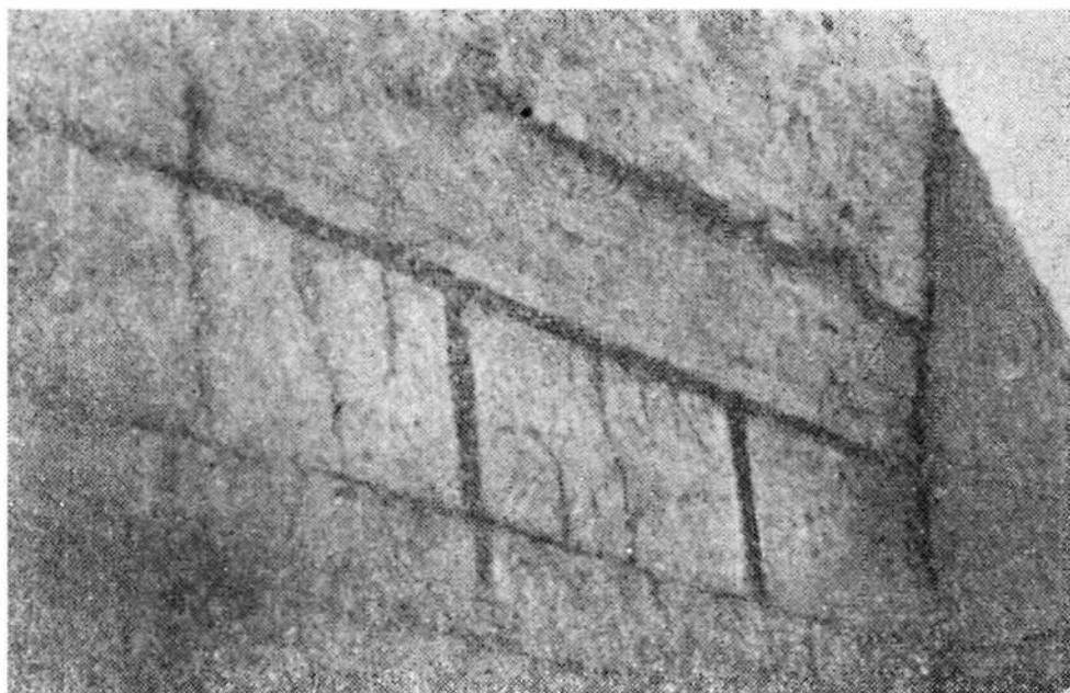
Рис. 26. Городище Калаи Кахкаха II. Помещение I. Деталь южной стены.
