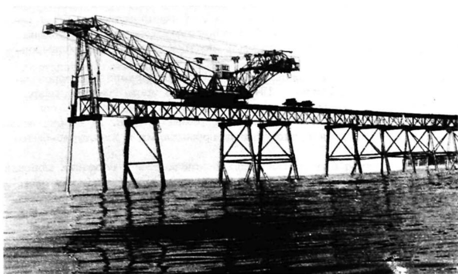
Рис. 1. Современный эстакадостроительный агрегат "Гипроморнефть-20"
