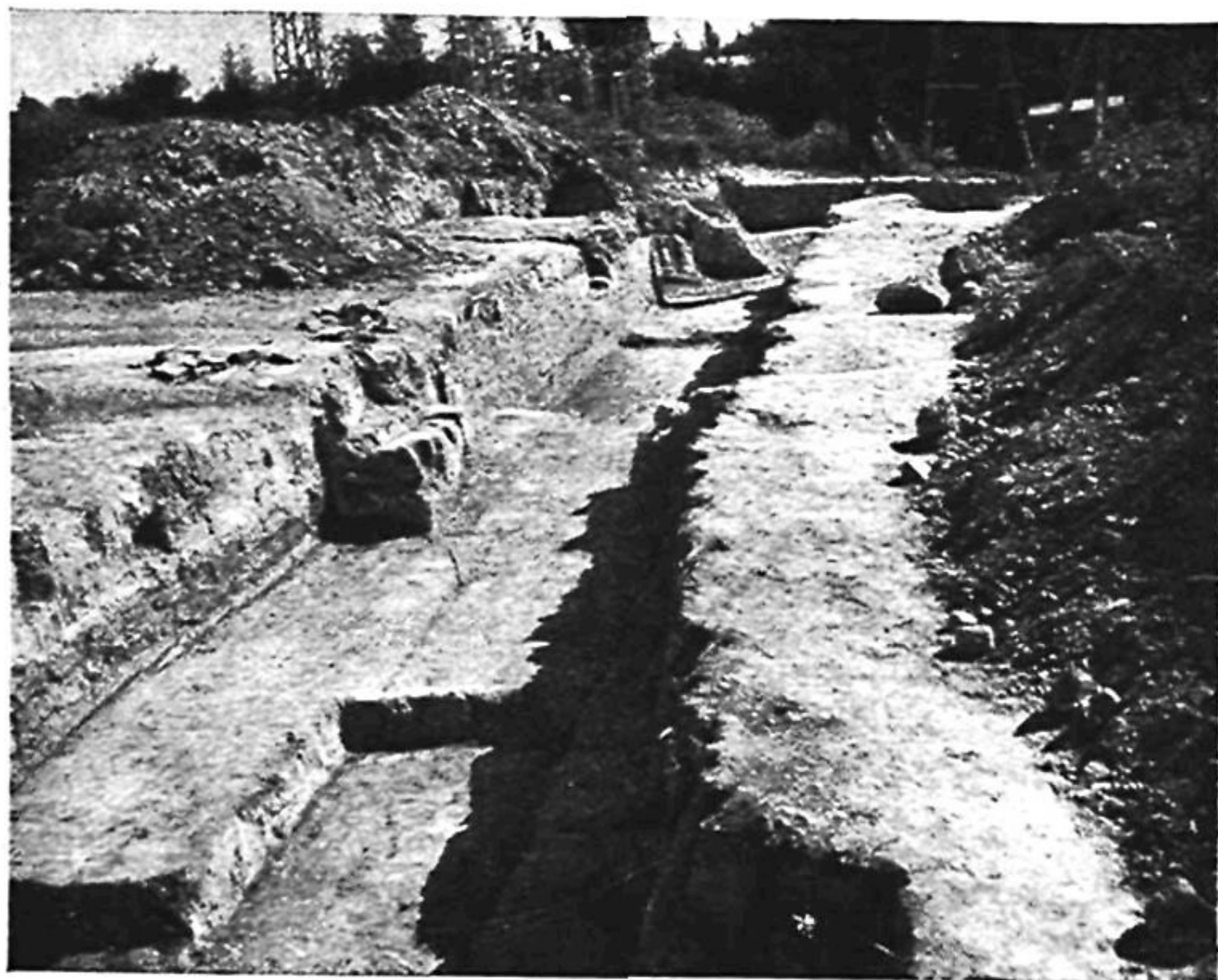
Рис. 6. Коридор в западной части цитадели
