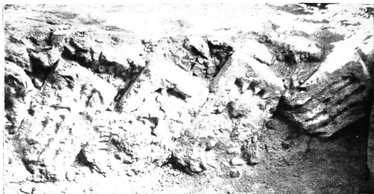
Рис. 8. Борозды на сводовых кирпичах. Рухнувший свод в помещении 102
