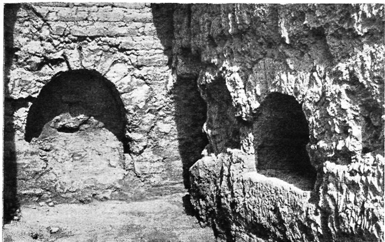
Рис. 70. Помещение 43. Северо-восточная часть комнаты
