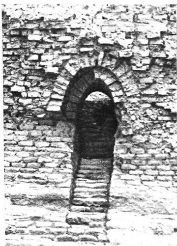
Рис. 20. Помещение 5В. Сводчатое перекрытие прохода
