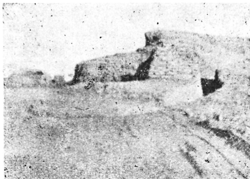
Рис. 59. Капарас. Башня 5 1 — общий вид;
