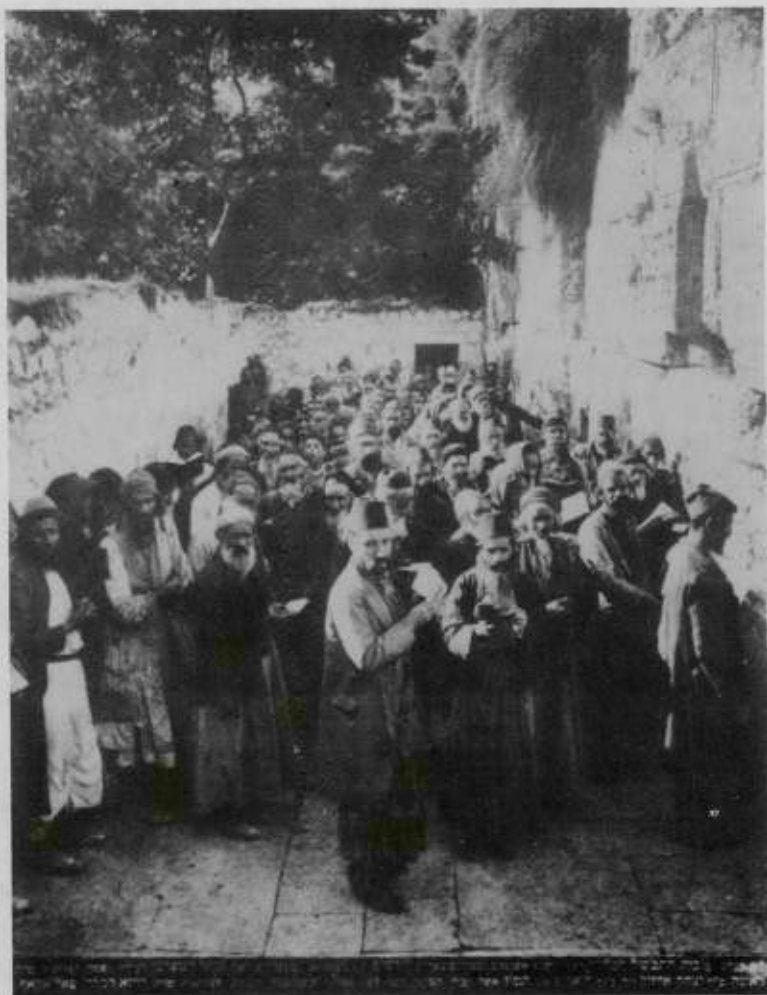
סימטת הכותל. צילום מאת הצלם הירושלמי המפורסם – צדוק בסן – 1910. בכיתובית המקורית בתחתית הצילום רשום – "תמונת עניים מ"בית התבשיל" הכללי לעניי ישראל, אשכנזים וספרדים בעיה"ק ירושלים, העומדים ומתפללים לפני כותל מערבי לעילוי נשמת הצדקנית מרת פומה ראשה, ליארצייט.."
