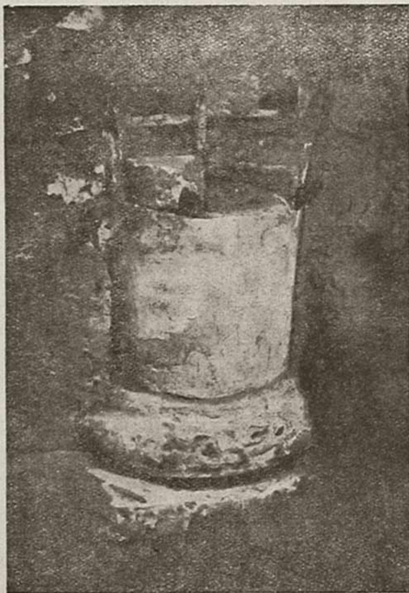
Рис. 1. Полуколонна западной стены.
