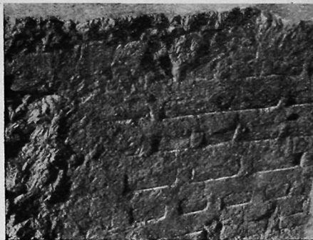
Рис. 19. Тип кладки «кирпич вразбежку»
