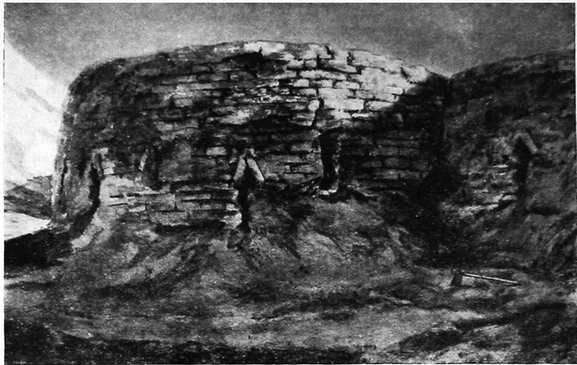
Рис. 51. Древняя башня (рисунок Г. Н. Никитина; подготовлен к печати В. Н. Кедриным)
