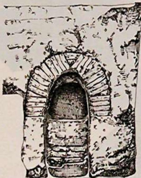
чатая, замок выполнен из кирпичей, положенных «в елочку», имеется обвод из плашмя положенных кирпичей. Замок находится на уровне 3,4 м от пола, первоначальная его высота порядка 3,5—3,6 м от пола. Самой большой была арка, перекрывавшая проход из помещения II в помещение I, от нее сохранились лишь несколько кирпичей у пят. Пролет был равен 2,2 м, высота пяты над полом 3,35 м, реконструируемая высота замка арки — около 4,5 м; она имела двойной обвод из плашмя положенных кирпичей.
