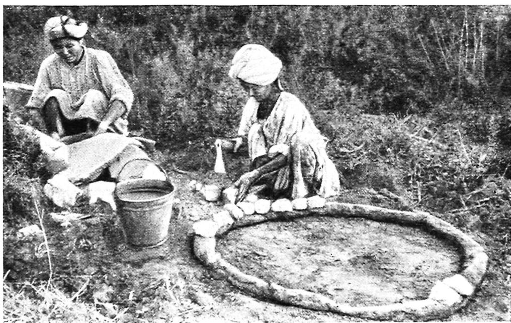
Рис. 8. Процесс изготовления первый этап—укладка нижнего слоя глиняной стенки; второй и третий этапы возведение стенок тандыра из перемежающихся слоев глины и комьев пахсы;
