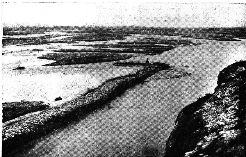
Шох-шабба, тош ва чимлардан ишланган каналга сув боғлаб олувчи тўғон
