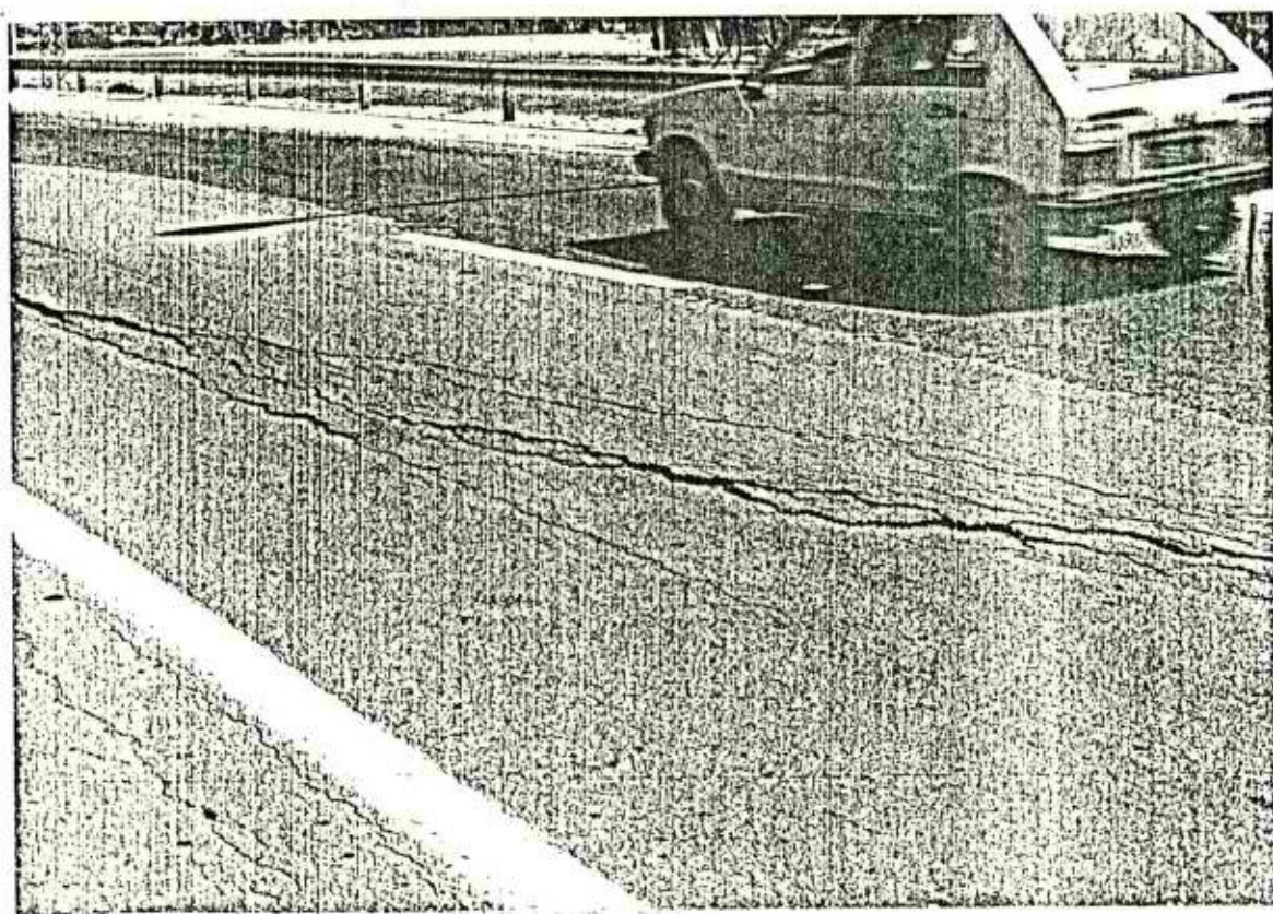
התמונה צולמה בכביש מס' 1 (ת"א - ירושלים) בקטע שעל גשר הרכבת ליד ת"א. הרס המבנה והמסעה כתוצאה משקיעת המילויים מעל הגשר.
