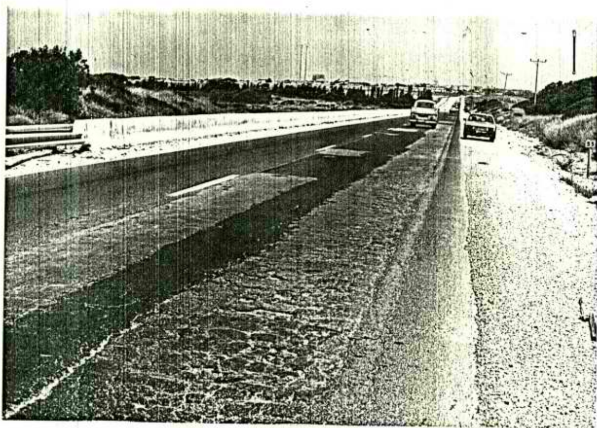
התמונה צולמה בכביש מס' 2 (תיא - חיפה) בקטע בין מכמורת וגבעת אולגה במסלול המזרחי. הרס המסעה והמבנה בנתיב העמוס כתוצאה מאי טיפול בזמן ועומס רב. הטיפול הנדרש: קירצוף הנתיב ההרוס, חיזוקו וריבוד בשני הנתיבים יחדיו.
