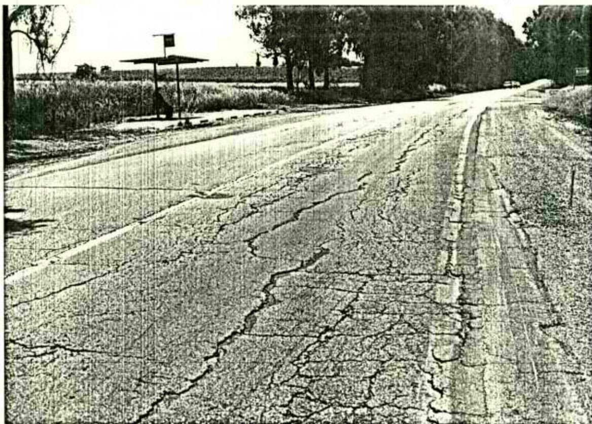
התמונה צולמה בכביש מס' 424 (רמלה - לטרון) בקטע ליד שעלבים. הרס המבנה והמסעה כתוצאה מנקוז לא נכון של הכביש ועומס רב. הטיפול הנדרש: הסדרת נקוז לאורך הכביש ושיקום.
