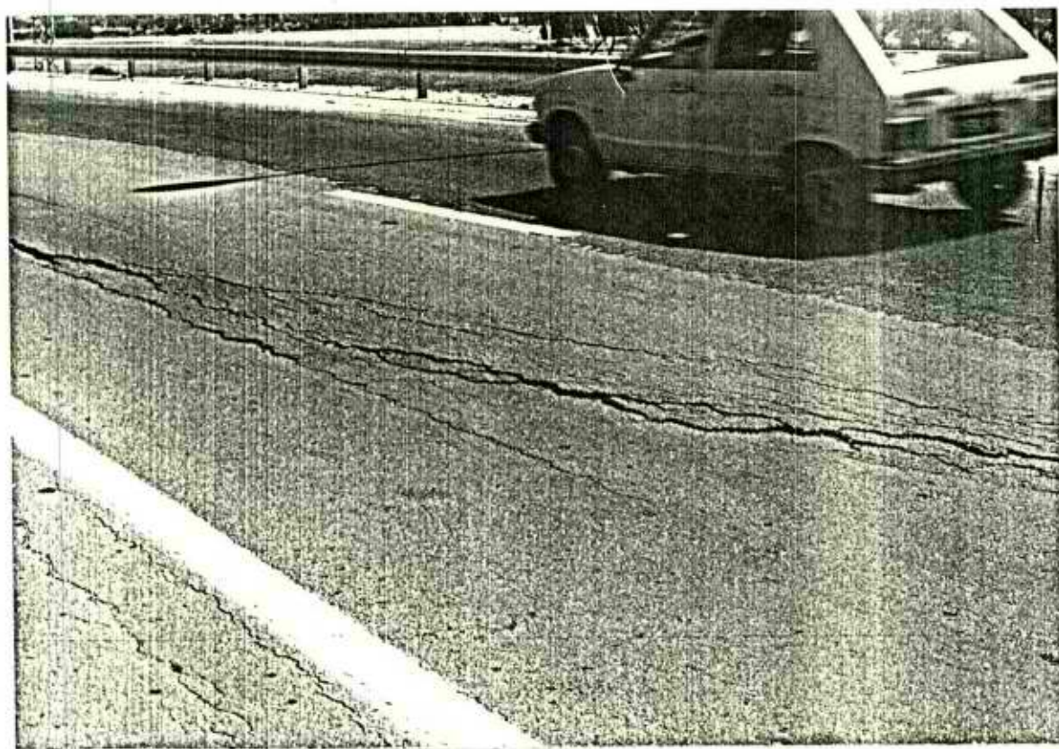
התמונה צולמה בכביש מס' 1 (תיא - ירושלים) בקטע שעל גשר הרכבת ליד תיא. הרס המבנה והמסעה כתוצאה משקיעת המילויים מעל הגשר. הטיפול הנדרש : שיקום
